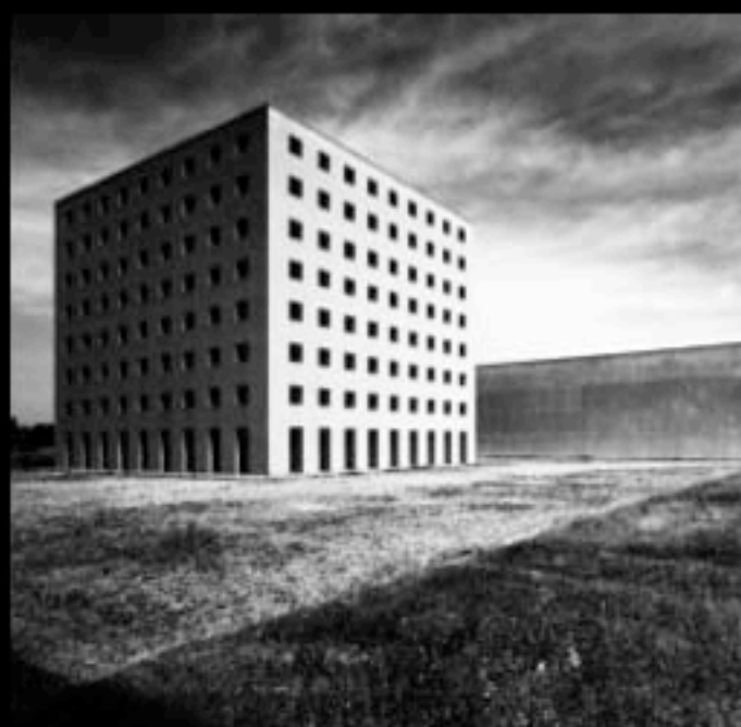
Mimmo Jodice, Attesa – Opera 7 , 1994 L'edificio è il Cimitero Monumentale di San Cataldo a Modena , Aldo Rossi, 1987
